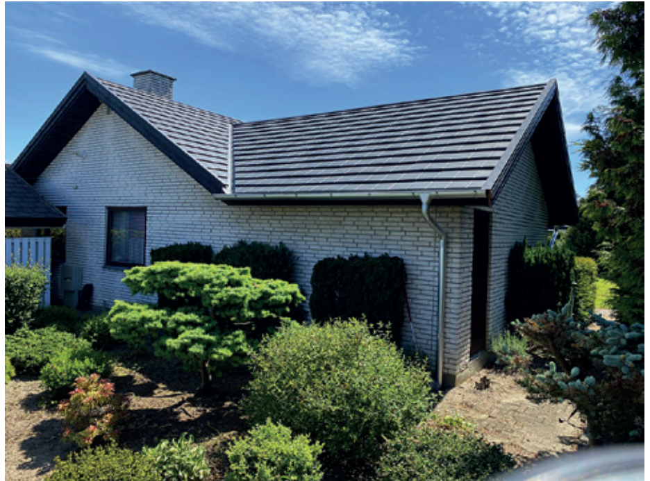
▲ Een referentiehuis met een DECRA Qube gelakte dakpan in de kleur antraciet, geproduceerd door RoofTG.
